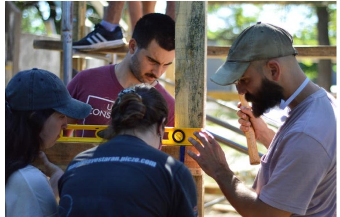
Imagen 12. Colocación de soleras/vigas.
