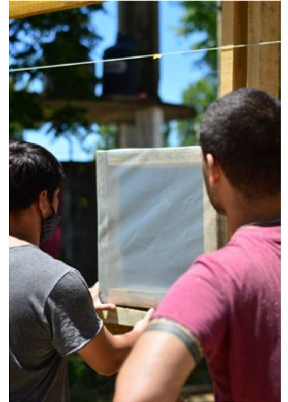
Imagen 06. Presentación de unos de los frames móviles conformantes de la envolvente.
