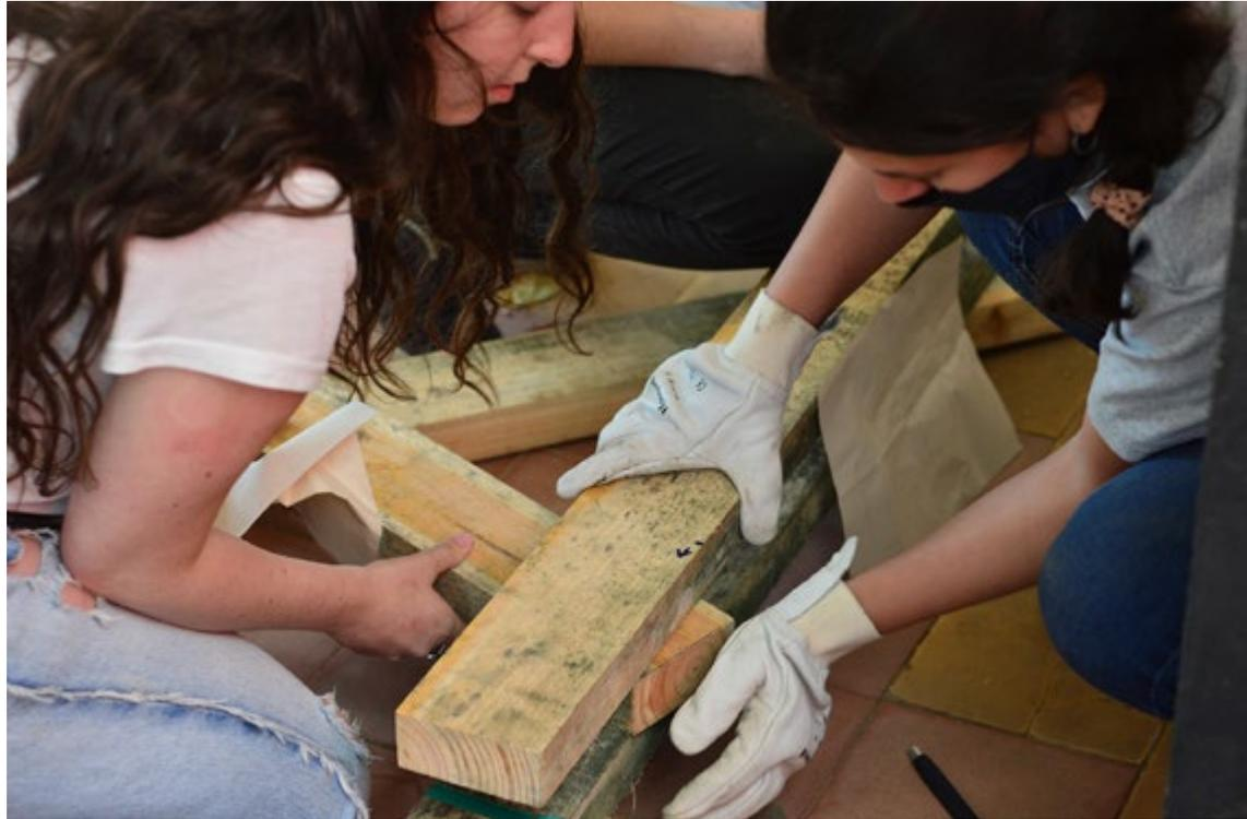
Imagen 13. Cortado y ensamblado de las cerchas.
