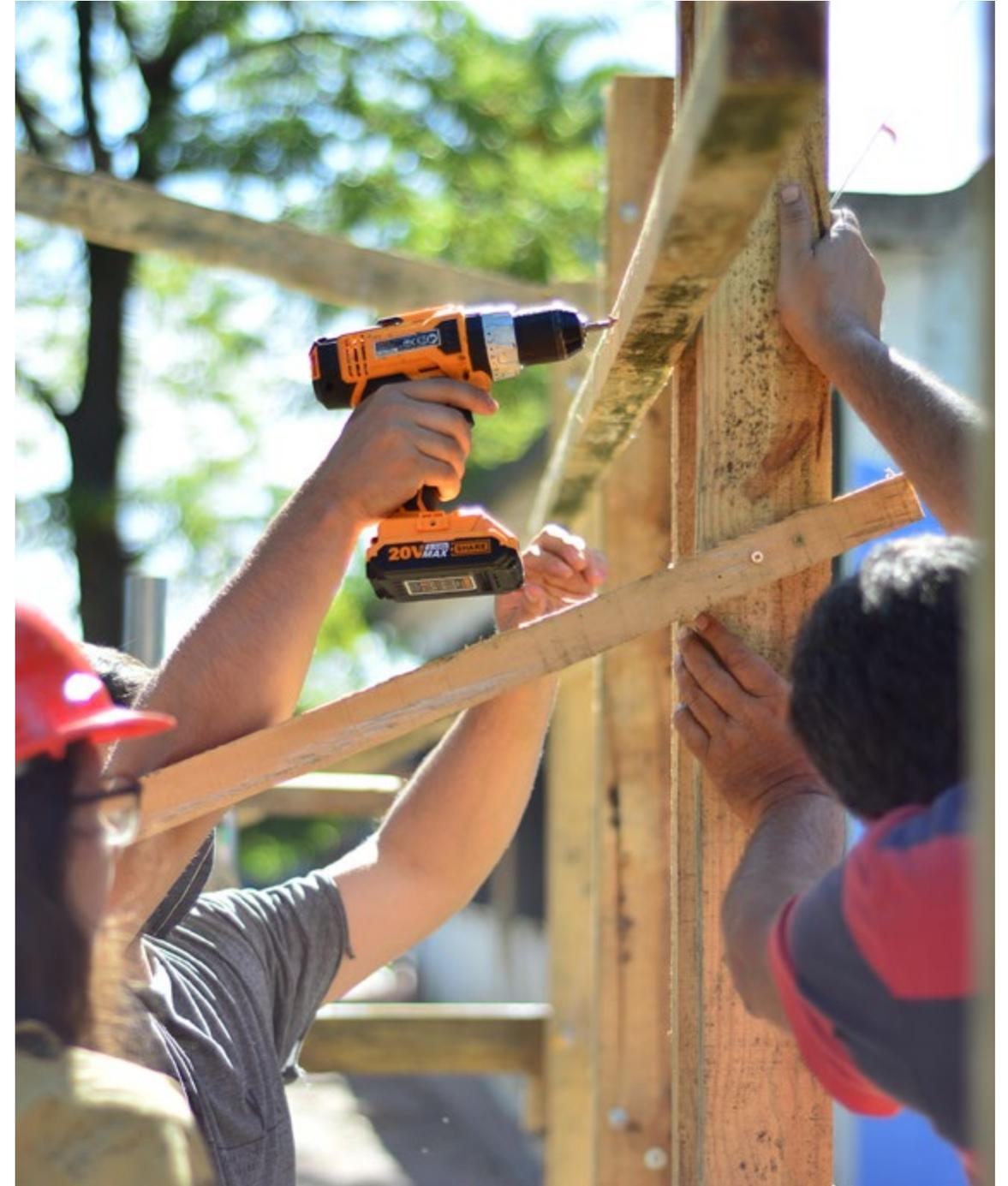
Imagen 14. Colocación de riostras provisionarias.
