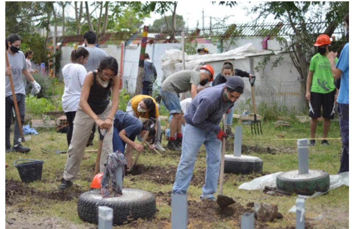
Imagen 09. Excavación de pozos para los dispositivos de cimentación.
