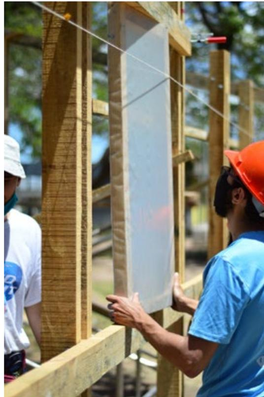
Imagen 05. Presentación de unos de los frames fijos conformantes de la envolvente.
