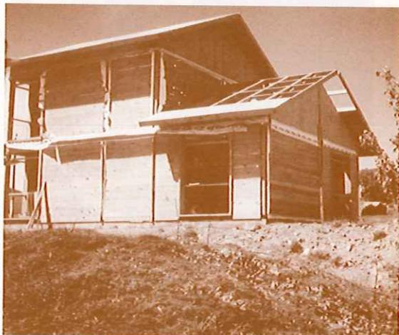
Los paneles cuentan con una estructura interior con montantes de 2"x 4" que transmiten la carga a la cimentación. Tienen diagonales de arriostamiento y están anclados a la fundación mediante bulones empotrados en el hormigón.
