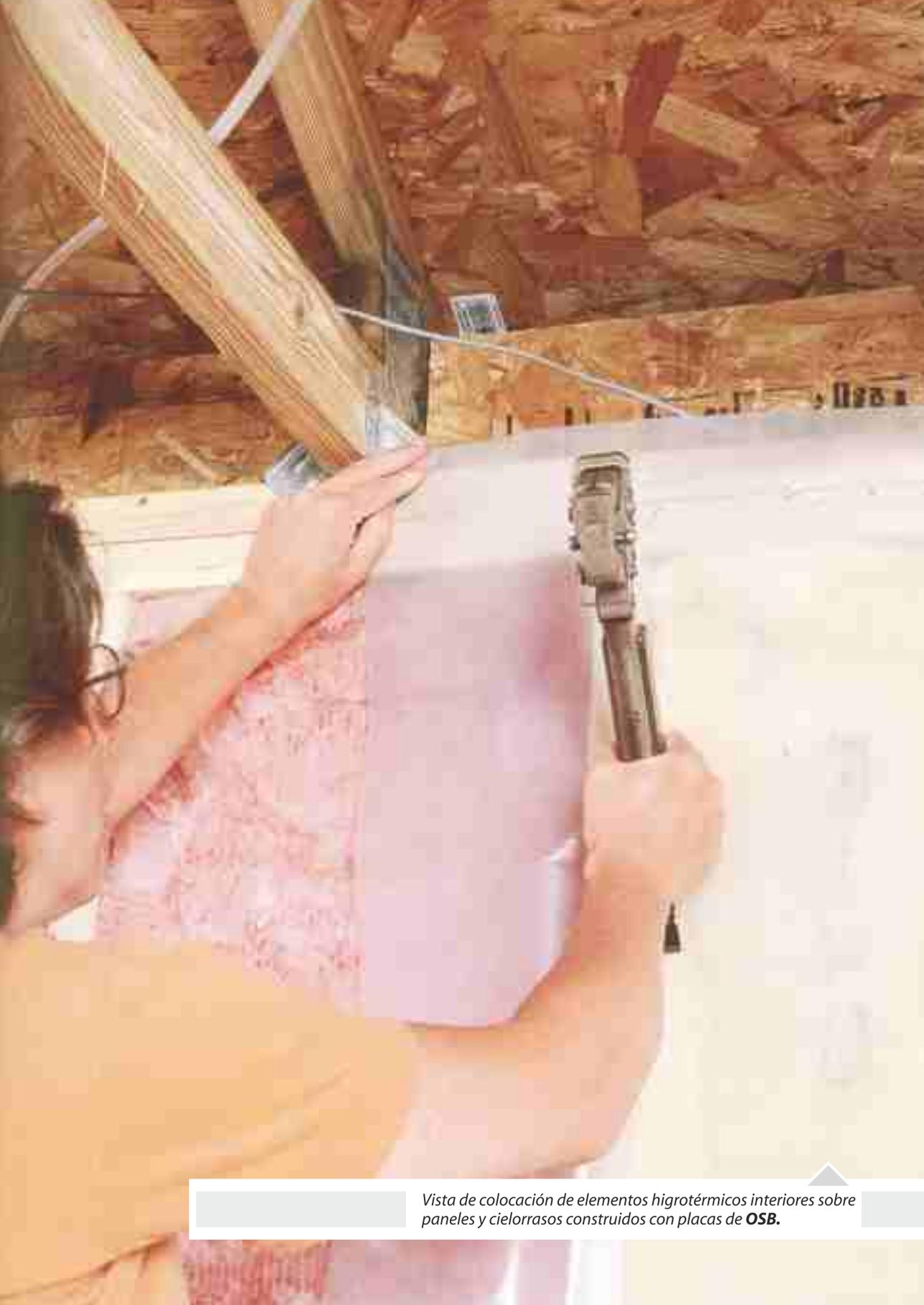
*Vista de colocación de elementos higrotérmicos interiores sobre paneles y cielorrasos construidos con placas de OSB.*
