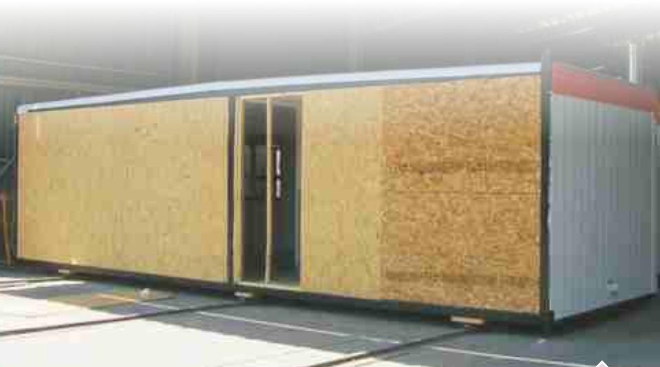
*El **OSB** es sumamente útil para la realización de viviendas volumétricas en base a paneles. Son terminados en fábrica y enviados a obra.*
