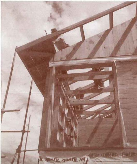
Se constituye por vigas de 2"x6" o 2"x8" según diseño sobre las cuales se colocan las tablas de pisos o tableros contrachapados que pueden quedar a sus vez vistas hacia abajo. Estas estructuras tienen diversos diseños pudiéndose agregar varios elementos que colaboren en la solución de los problemas acústicos, apoyos de gomas microporosas, incorporación de lana de vidrio termoacústica y hasta carpetas de hormigón liviano sobre las tablas de piso.
