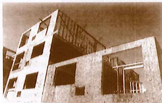
Las actuales sistemas espaciales en madera se basan en la combinación, en sentido vertical y horizontal, de módulos tridimensionales, bien autoportantes, bien asociados a una estructura general de esqueleto. Reducen los tiempos de producción, suministro y montaje y son reciclables. En la fotografía de la derecha, imagen de montaje de las unidades de habitación para la extensión de un hotel en Bezau, Austria (Kaufmann 96, 2001).
