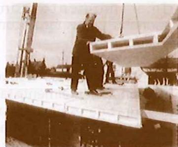
Es frecuente el empleo de los mismos elementos para resolver tanto muros, como forjados o cubiertas. Una vez colocados en obra proporcionan superficies resistentes que pueden entrar inmediatamente en servicio.
