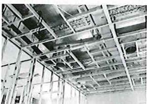
agrande el orificio en la placa de yeso. Estas deben responder a ciertos estándares. En particular las especificaciones constructivas responden a las normas ASTM que son las que recomiendan los proveedores del sistema y refieren al Calibre de los perfiles y normas en lo relativo al espesor del galvanizado.
