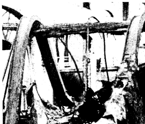
Consecuencia de un incendio sobre elementos estructurales de madera y metal. Doc A.I.T.C. Boletín del American Institute of Timber Construction, 1954
