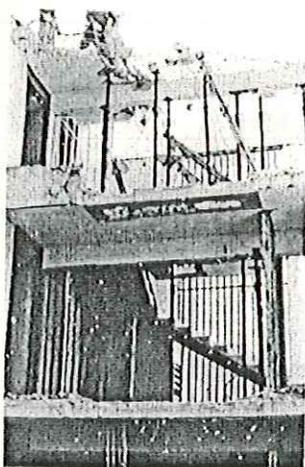
Fotografía N° 4. Detalle de demolición del núcleo de circulación por la ausencia de juntas de construcción.
