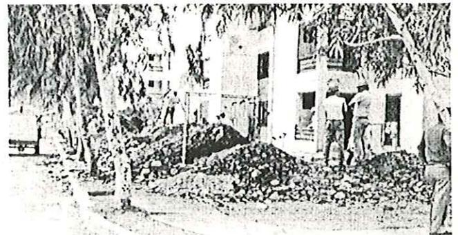
Fotografía Nº 11. Nótese la disposición de los Eucaliptos alineados en forma paralela al edificio, lo cual intensificó el efecto de desecación
