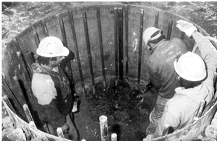
Picado de pilotes de 2 m de diámetro y con 34 Fe 32 mm
