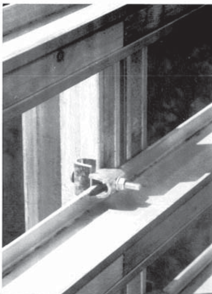
DETALLE DE NUDO EN UN ENCOFRADO DE MURO CON VIGAS DU-AL
